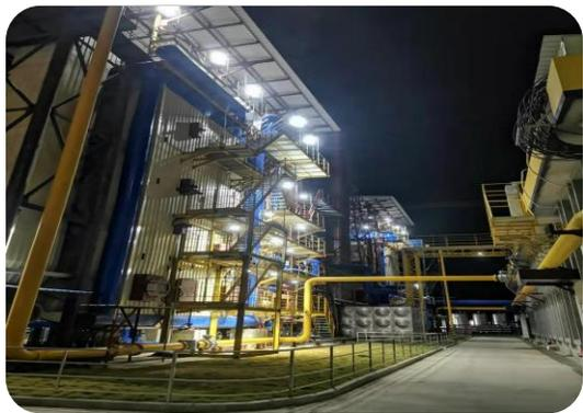
**供能模式：**利用燃气轮机、余热锅炉和调峰锅炉，建设配套热力管网为园区提供蒸汽和电力。（部分投产）
